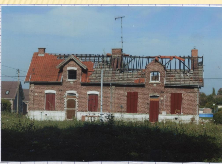
Une maison des mines de la cité n°10
